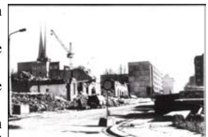
Abriss und Neubau Sonnenstraße
