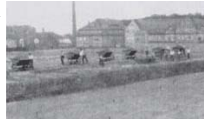
Stadionbau des PSV
